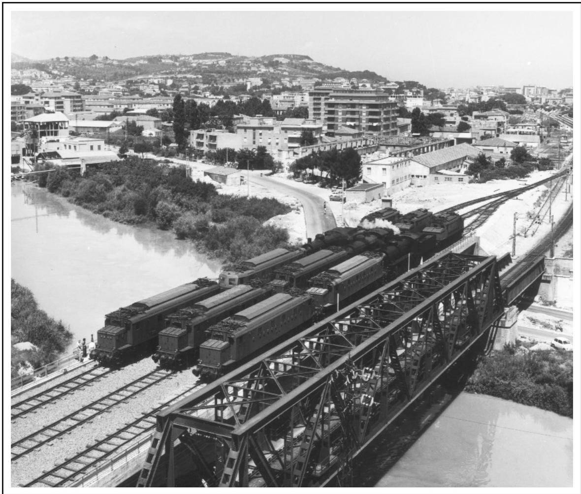
*Pescara, 21 giugno 1968: operazioni di collaudo del nuovo ponte sul Pescara dotato per lo scopo di tre binari provvisori. Si riconoscono 5 locomotori E428 di prima serie, un E428 di seconda serie, 3 locomotive a vapore 740 e 3 locomotori E626.(Foto FS).*
