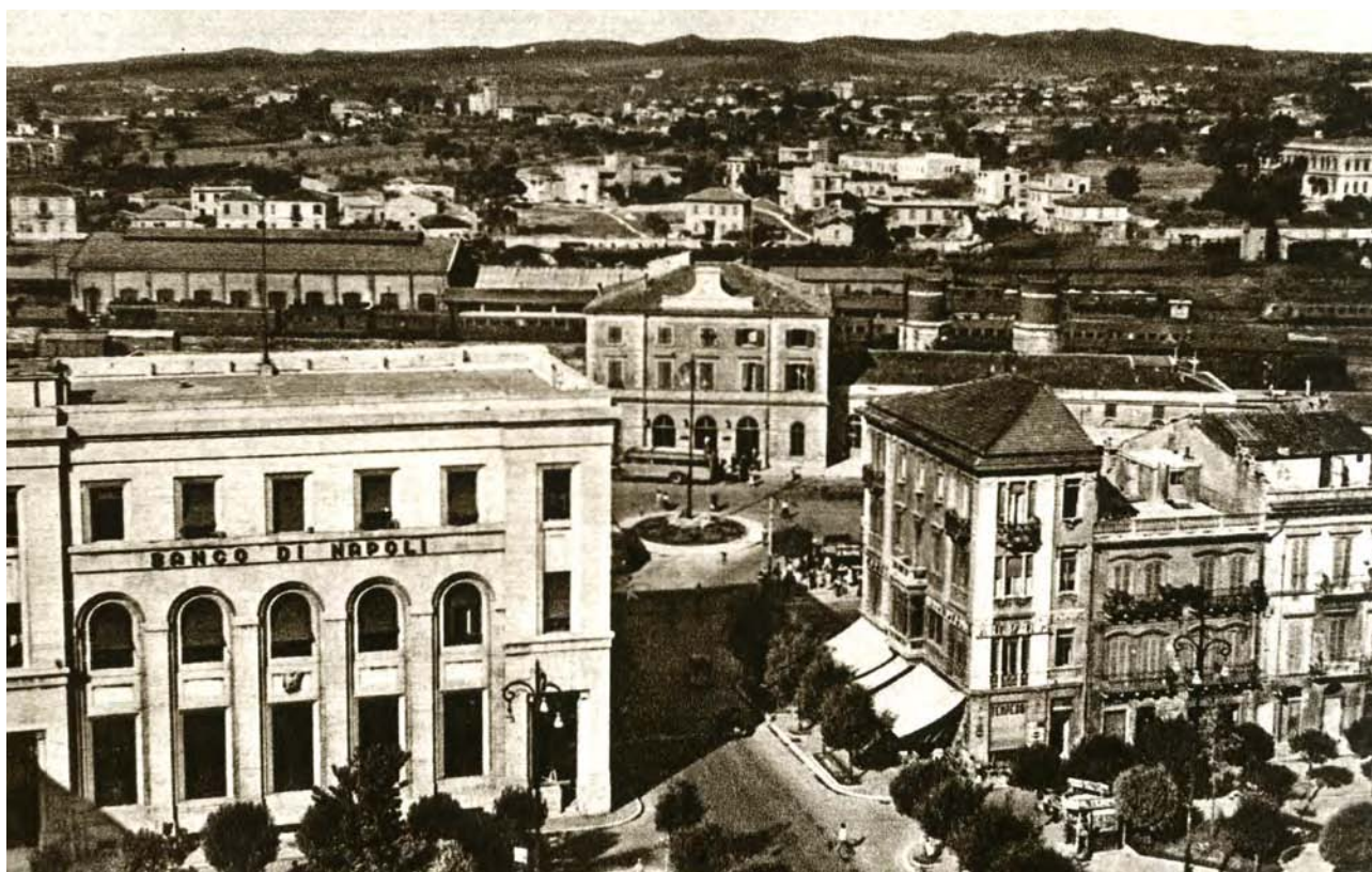
Panoramica degli impianti ferroviari di Pescara Centrale, anni cinquanta del Novecento. Collezione Lello Tiberio.
