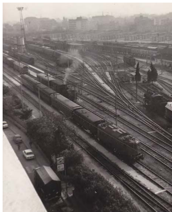
E' appena partito dal secondo binario di Pescara Centrale l'accelerato per Ancona, alla testa di una locomotiva FS del Gruppo E 424; si notano le locomotive a vapore dei Gruppi 835 (in manovra) e 740 (al treno soccorso della R.L.), anni settanta del Novecento. Collezione Achille Rasetta.
