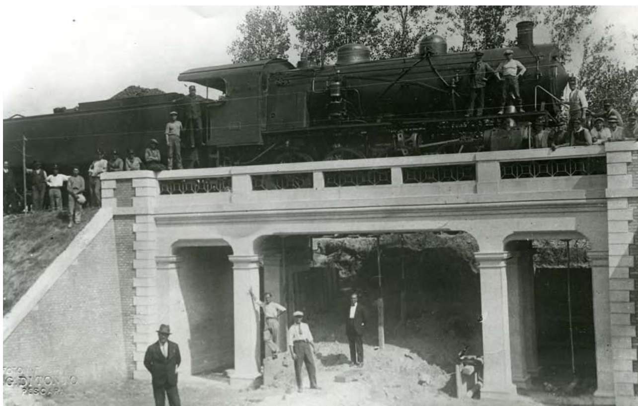
Personale tecnico ferroviario e maestranze d'impresa esecutrice assistono al collaudo del ponte nei pressi della stazione FS di Pescara Porta Nuova (attuale via Orazio) col peso della locomotiva FS 735, fine anni venti del Novecento. Collezione Lello Tiberio.
