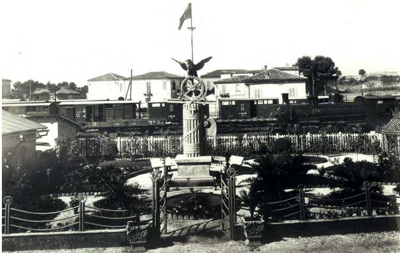
Caratteristico e ben curato giardinetto all'interno del Deposito Locomotive di Pescara Centrale (sullo sfondo una locomotiva "Caprotti" FS 625 e diversi carri merci in sosta), anni trenta del Novecento. Collezione Lello Tiberio.
