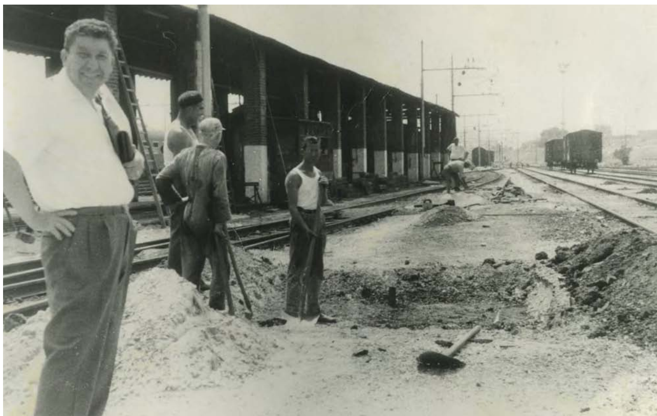
Personale del “Servizio Lavori” durante una manutenzione all’armamento del Deposito Locomotive di Pescara Centrale, anni sessanta del Novecento. Collezione Lello Tiberio.
