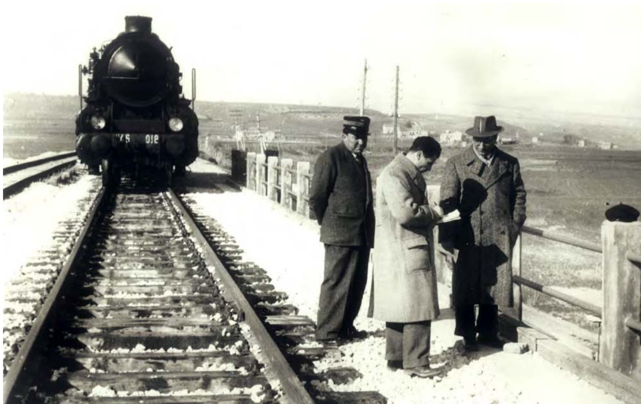
Prove di collaudo per il futuro doppio binario del ponte sul torrente "Salinello", affidate alla locomotiva FS 745.018, anni cinquanta del Novecento. Collezione Lello Tiberio.
