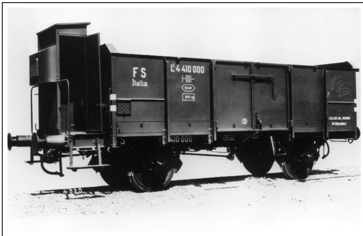
Antichi carri FS con garitta per il frenatore. (Foto FS).
