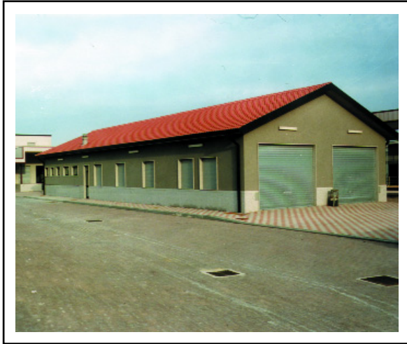
Montesilvano, anno 1990, il nuovo fabbricato servizi.
