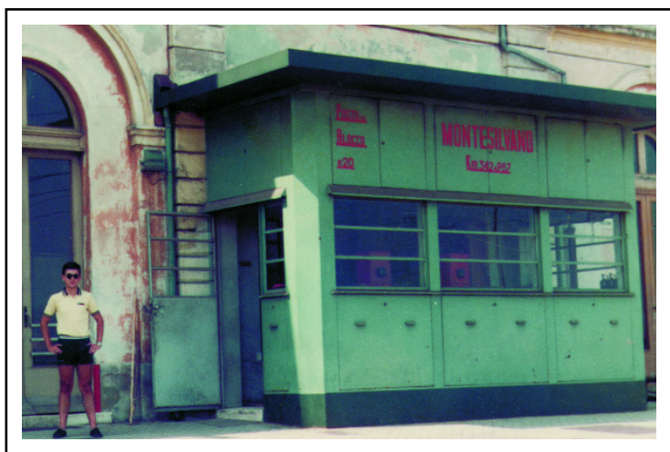
Montesilvano, anno 1981, la "cabina di blocco" dell'ufficio movimento.
