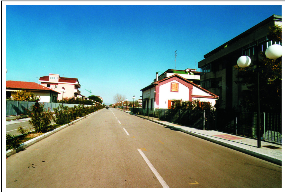
Montesilvano, anno 2003, l'ex tracciato ferroviario FS realizzato quale sede della futura filovia, con attigua pista ciclabile, nei pressi dell'ex casello in zona "Mazzocco".
