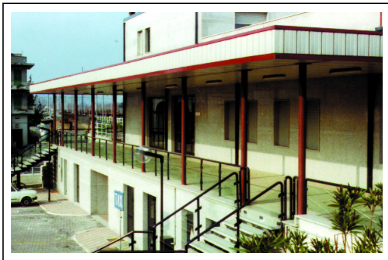
Montesilvano, anno 1991, lato esterno del fabbricato viaggiatori a lavori ultimati (opere civili).
