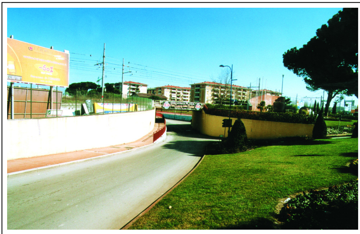
Montesilvano, anno 2003, nuovo arredo urbano complementare al sottovia nei pressi dell'ex passaggio a livello di Viale Aldo Moro.
