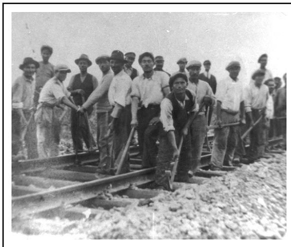
Secondo dopoguerra, operai al lavoro di ricostruzione della sede ferroviaria.
