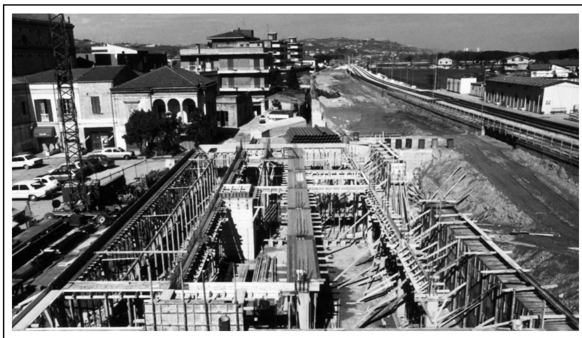
Montesilvano, anno 1988, il nuovo cantiere ha definitivamente soppresso vecchi luoghi ferroviari.
