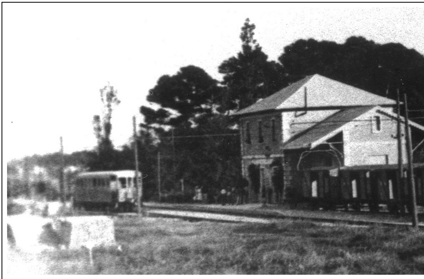
Anni '30, la stazione F.E.A. di Montesilvano Marina, attigua agli impianti FS.
