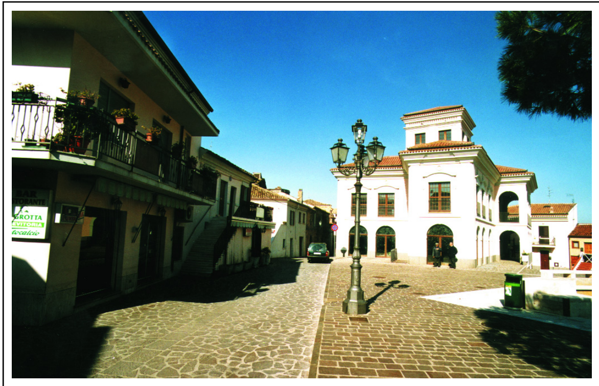
Montesilvano Colli, anno 2003, centro storico: ex palazzo "Lammutti".
