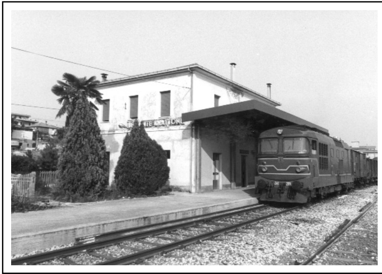
Stazione di Bellante Ripattono sulla ferrovia Teramo – Giulianova. Treno merci con locomotore Diesel-elettrico D343.2018. (Foto Pelucchini).
