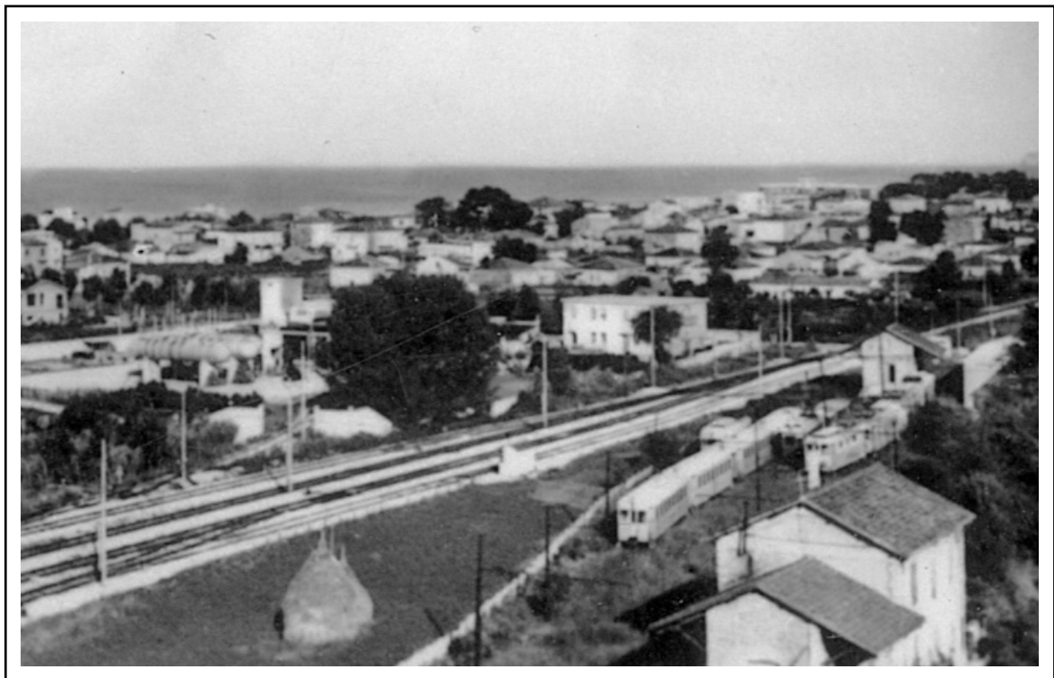
Montesilvano, primi anni '60, impianti FS e F.E.A., una volta collegati. A lato est è riconoscibile lo stabilimento "Liquigas" con relativo binario di raccordo. Si notino i numerosi mezzi, ormai accantonati, nei depositi F.E.A., e la vegetazione spontanea che comincia a ricoprire i binari del "trenino" prossimo alla dismissione.
