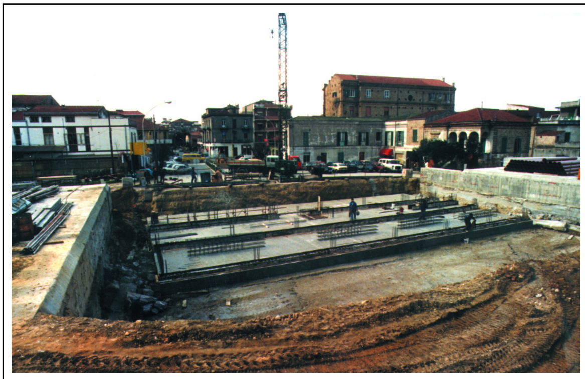
...e nel 1988, la "platea" in cemento armato del nuovo fabbricato viaggiatori.
