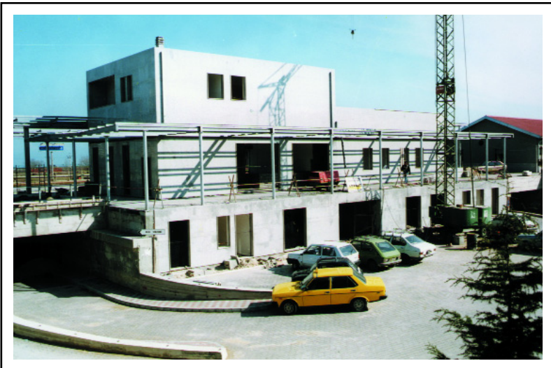
... e il nuovo fabbricato viaggiatori in via di ultimazione.
