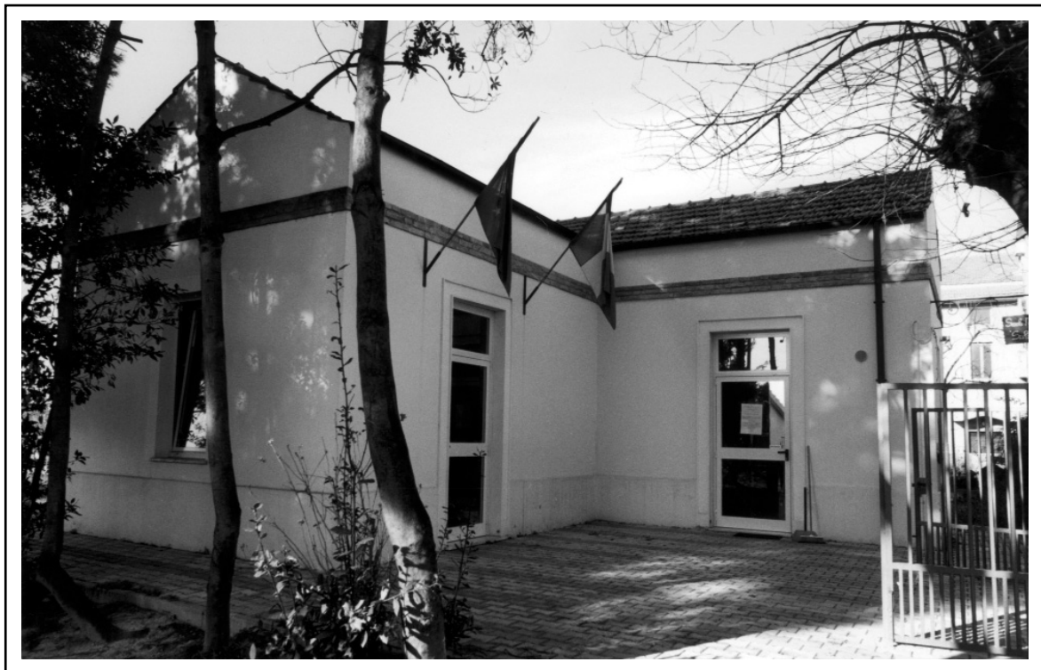
Anno 2003, il fabbricato della ex fermata F.E.A. di Montesilvano Colli, recentemente ristrutturato per uso Scuola Materna Statale.
