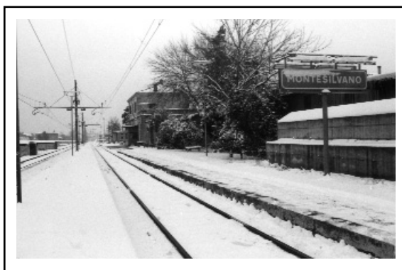
Anno 1986, piano dei binari di stazione innevato. Si scorgono i primi muri di contenimento per la sopraelevazione degli impianti.
