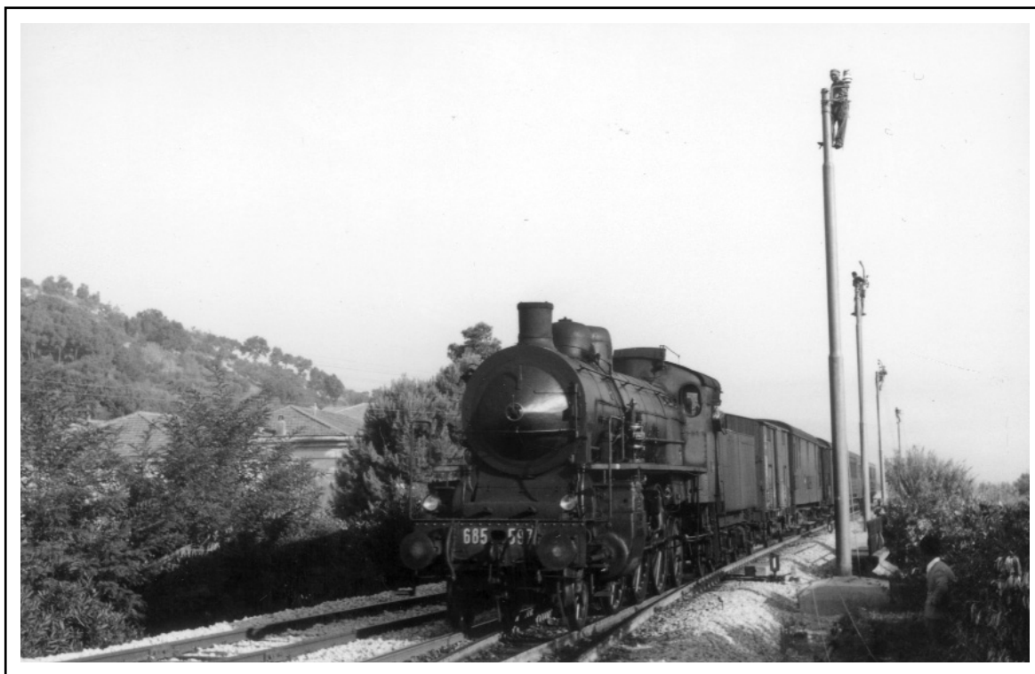
Anni '50, lavori di elettrificazione della linea adriatica. (Foto FS).
