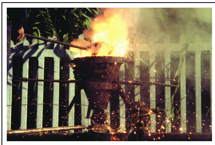
Montesilvano, anni '80, attività per la saldatura delle rotaie.
