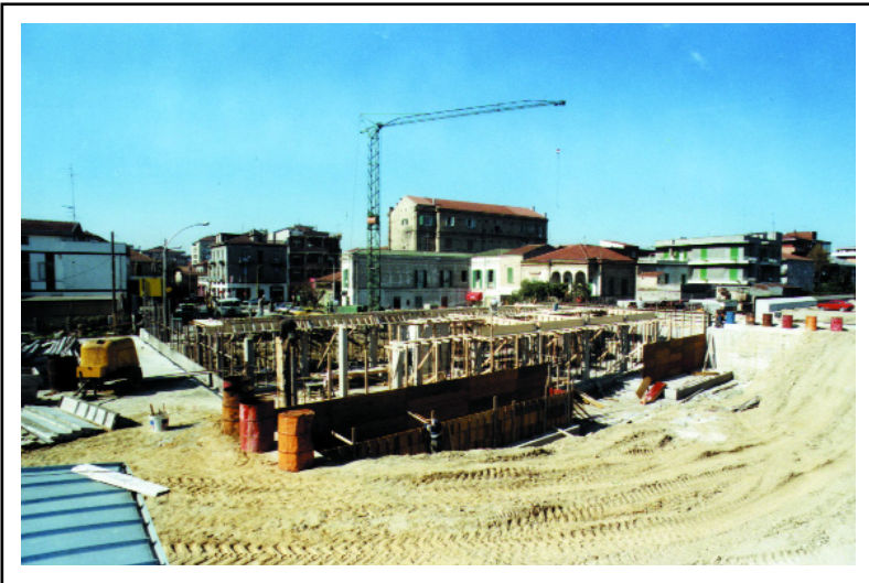
Montesilvano, anno 1988, strutture in cemento armato della nuova stazione.
