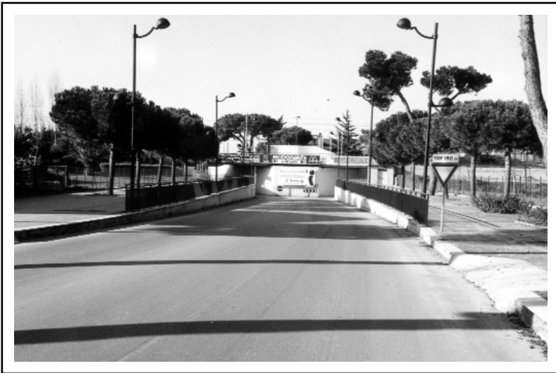
Montesilvano, anno 2003, Viale Aldo Moro nei pressi del sottovia.
