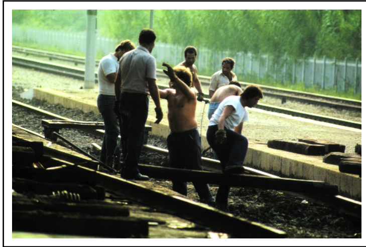
Montesilvano, anni '70, ferrovieri della "squadra lavori", per la manutenzione del primo binario di stazione.
