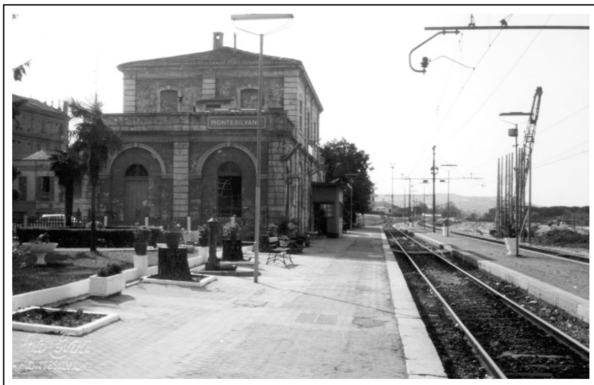
Fine anni '80, il terzo binario rimosso per dare spazio alle palificazioni delle nuove strutture in cemento armato.
