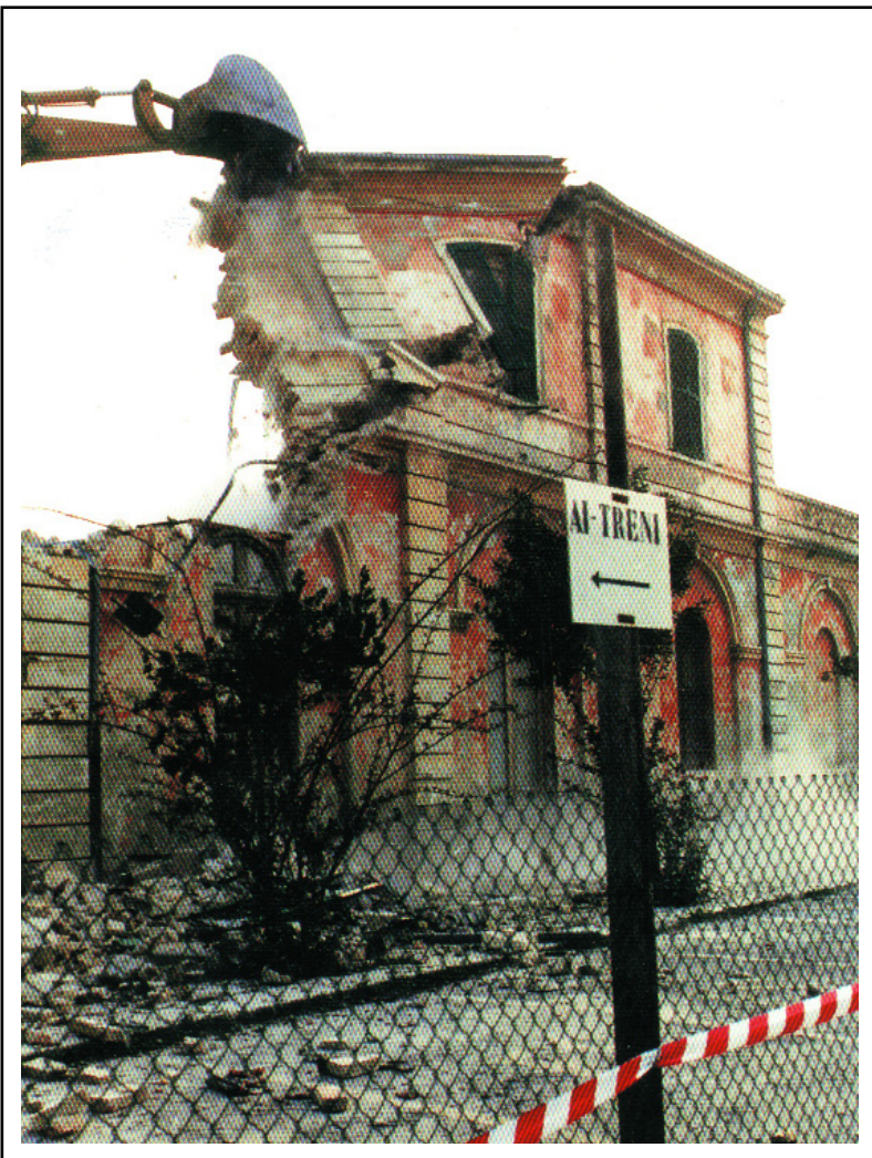
Segnaletica provvisoria durante i lavori di demolizione.
