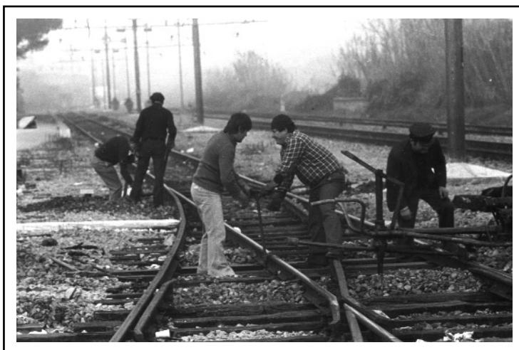
Montesilvano, anni '70, la manutenzione dello scambio "bloccabile" d'ingresso ai quattro binari dello scalo merci.
