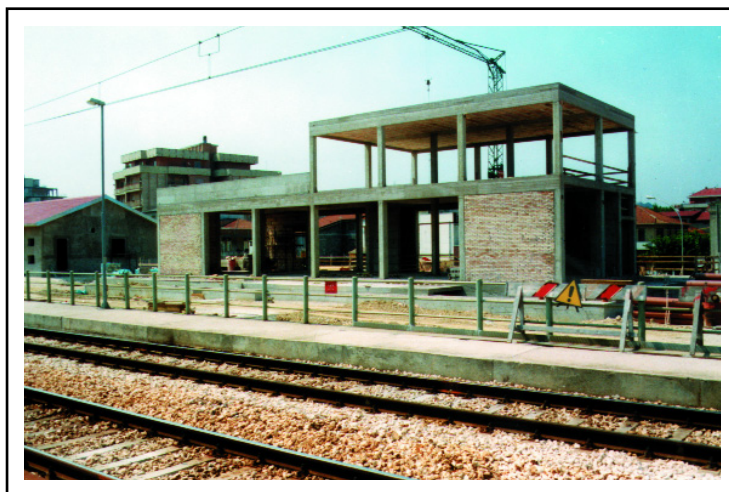
Anno 1990, fabbricati in costruzione.
