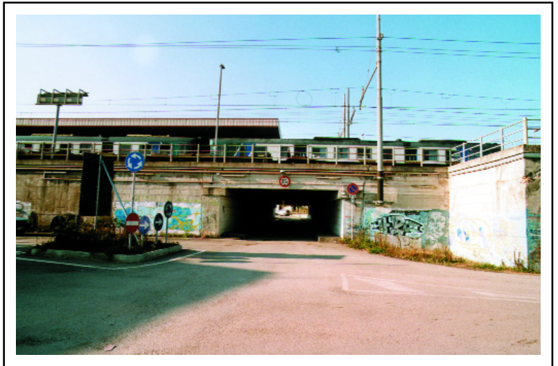
Montesilvano, anno 2003, piazzale lato est con sottopasso stradale.
