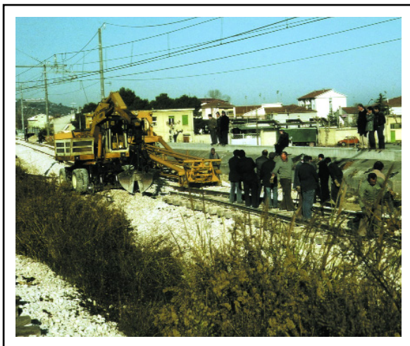
Anni '80, cantiere per la connessione dei tracciati ferroviari. (zona Via Cavour).
