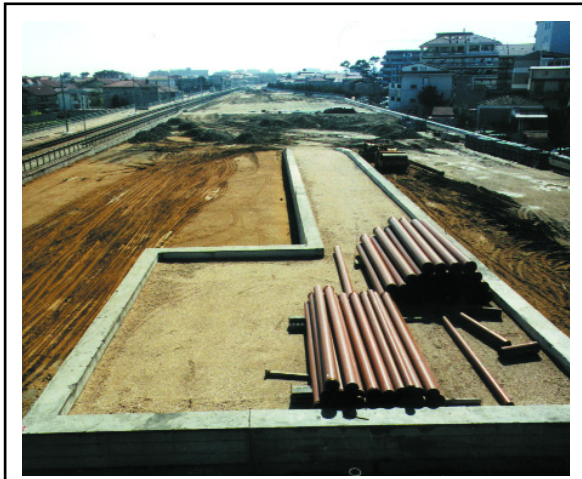
Fine anni '80, l'area del nuovo scalo merci in costruzione.
