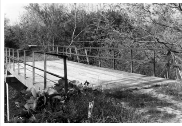
2004 - Ponte ferroviario F.E.A. sul fosso "Bottarane" fra i Comuni di Loreto Aprutino e Collecervino. - Collezione Ezio Faieta.
