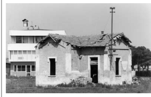
Anni '80 - Ex casa cantoniera "Muzii" nei pressi della Statale Adriatica in Montesilvano (demolita). - Collezione Ezio Faieta.
