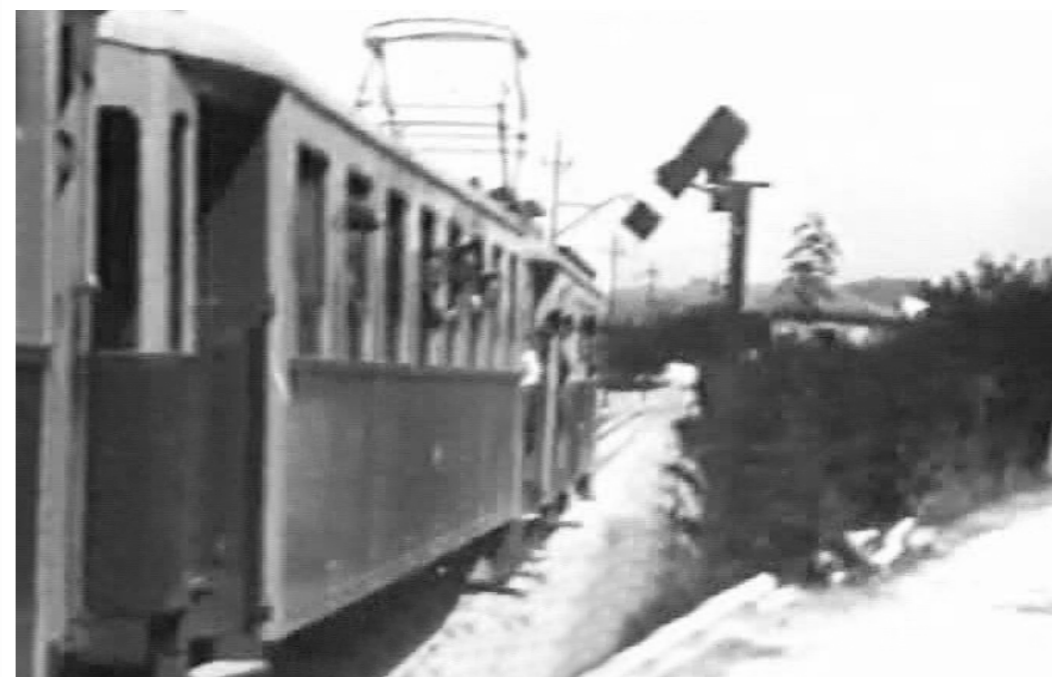
Anni '30 - Un convoglio diretto a Pescara oltrepassa il segnale ad ala semaforica di protezione, in arrivo alla stazione di Moscufo, in uscita dal ponte stradale e ferroviario sul fiume Tavo. - Collezione ACAF.
