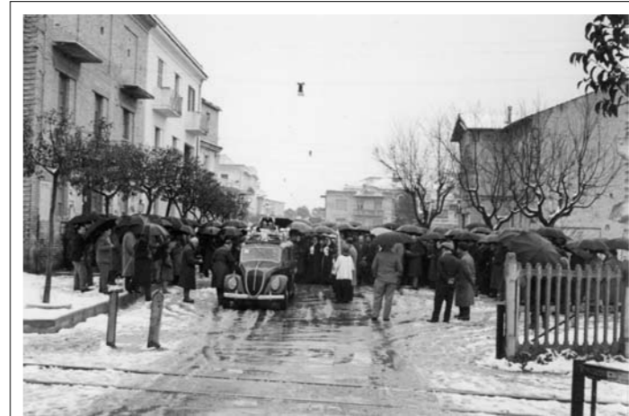
1960 - Riprese fotografiche di un corteo funebre in attraversamento del passaggio a livello custodito nel centro di Loreto Aprutino. - Collezione Gilda e Tullia Giovanetti, foto Sestili.
