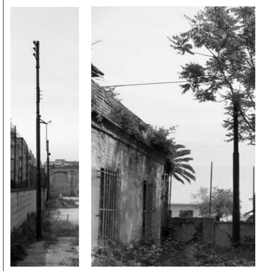
2008 - Pali per l'alimentazione elettrica della linea aerea, del tipo "tubolare"; ex deposito-officina di Pescara-Porto. - Collezione ACAF.
