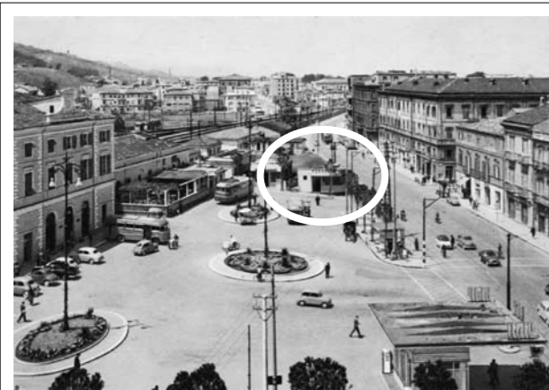
Piazzale della Repubblica a Pescara. In evidenza la stazione F.E.A. - Archivio personale ing. Ezio Faieta.
