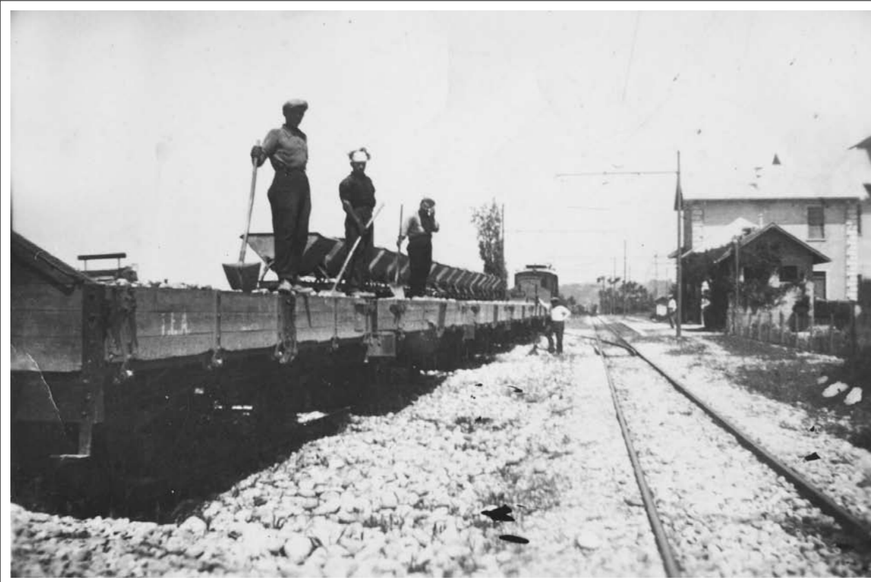
Anni '20 - Treno cantiere all'opera nei pressi della stazione di Moscufo (si notino, in quota rialzata, i carrelli del tipo minerario e da cava detti "Decauville", per il trasporto di pietrisco da riversare sui vagoni F.E.A. a sponde basse). - Collezione Giuseppe Castagna per ACAF.
