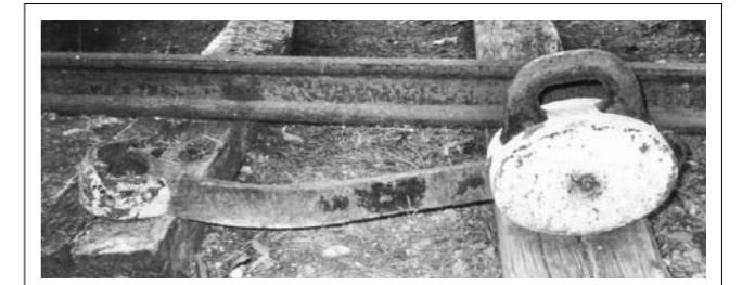
Anni '90 - Contrappeso, detto "Macaco", per deviatori F.E.A. nell'ex stazione di Cappelle Sul Tavo. - Collezione Achille Rasetta.
