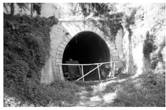
2004 - Portale d'ingresso della galleria nei pressi della stazione di Loreto Aprutino. - Collezione Salvatore Di Fazio.
