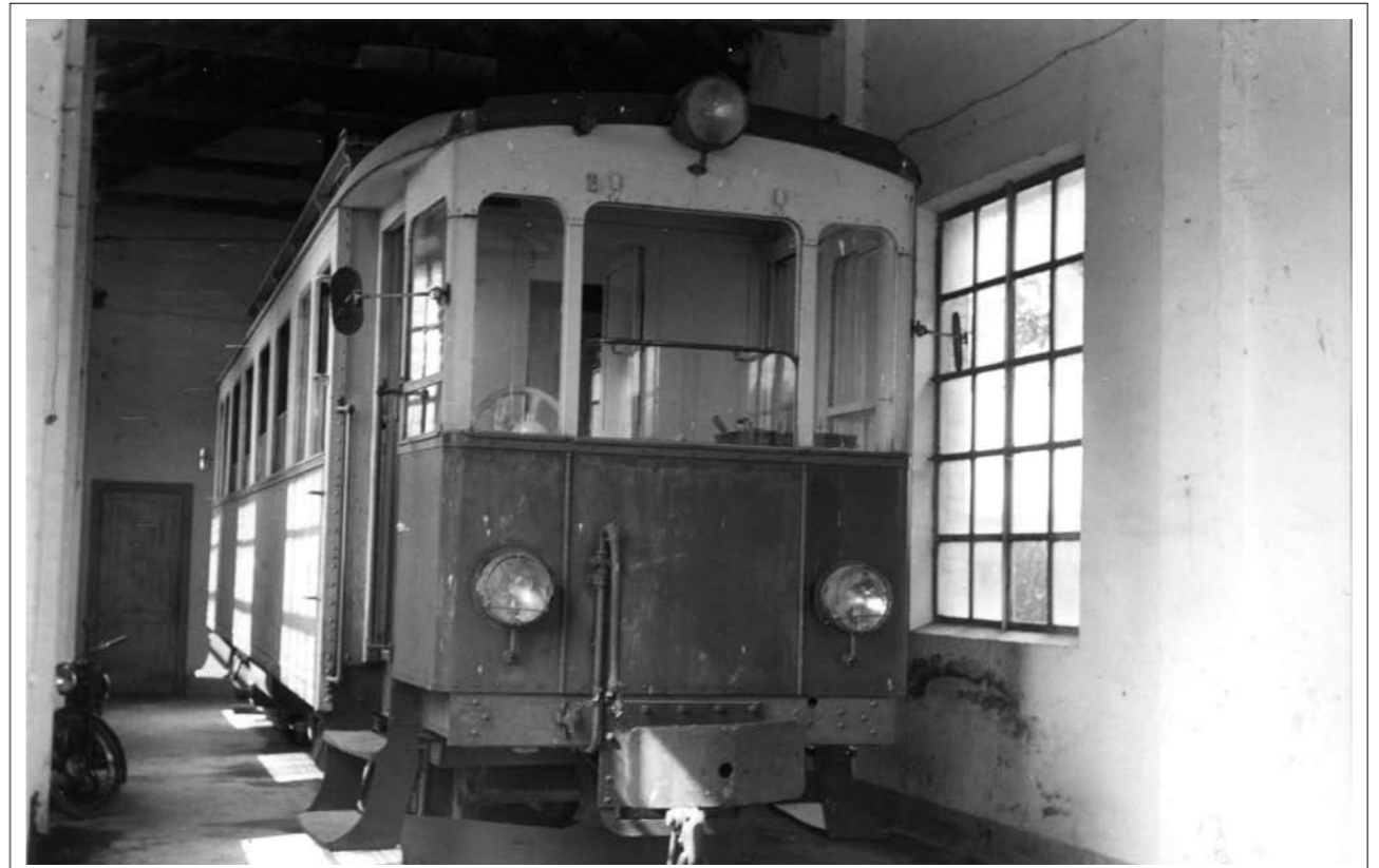
Maggio 1962 - Elettromotrice urbana in deposito a Montesilvano spiaggia. - Foto Renzo Marini.
