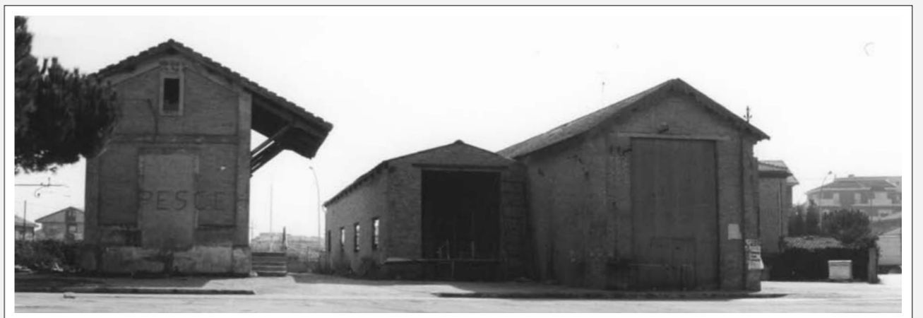
Anni '80 - Ex deposito-officina e magazzino trasbordo, con vista lato nord (demoliti), nella stazione di Montesilvano spiaggia. - Collezione Davide Cavuti.
