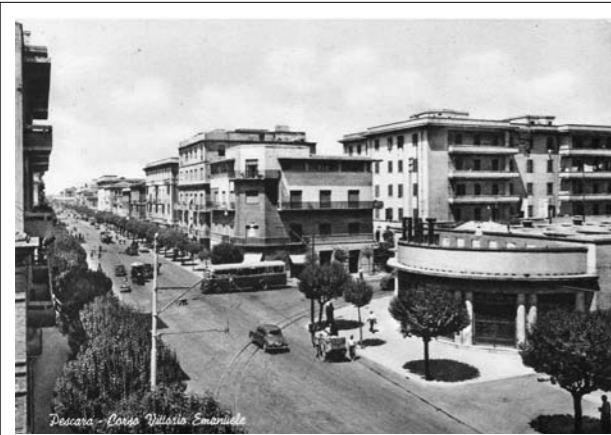
Pescara, attuale C.so Vittorio Emanuele II, all'incrocio con l'attuale Via Venezia, attraversato dal binario diretto ai depositi in Via Foscolo. - Collezione Salvatore Di Fazio.
