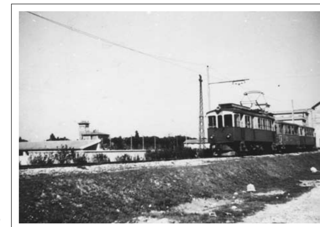
Ferrovia Sangritana. Treno a scartamento ridotto della prima elettrificazione. - Collezione Piero Muscolino.
