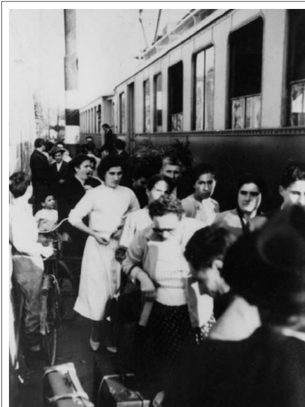
Movimento viaggiatori alla stazione F.E.A. di Pescara centrale. - Archivio personale Achille Rasetta.
