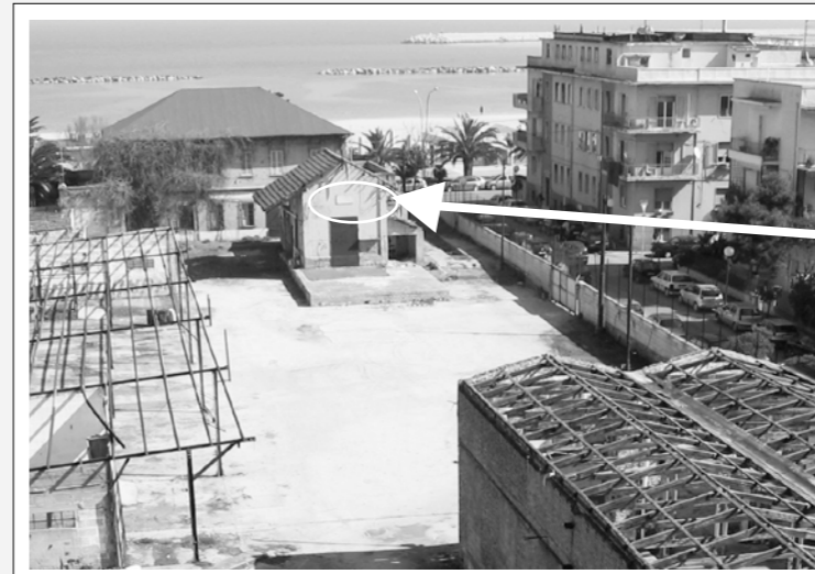
2008 - Piazzale interno con rimessa-officina della stazione di Pescara-Porto. - Collezione Salvatore Di Fazio.
