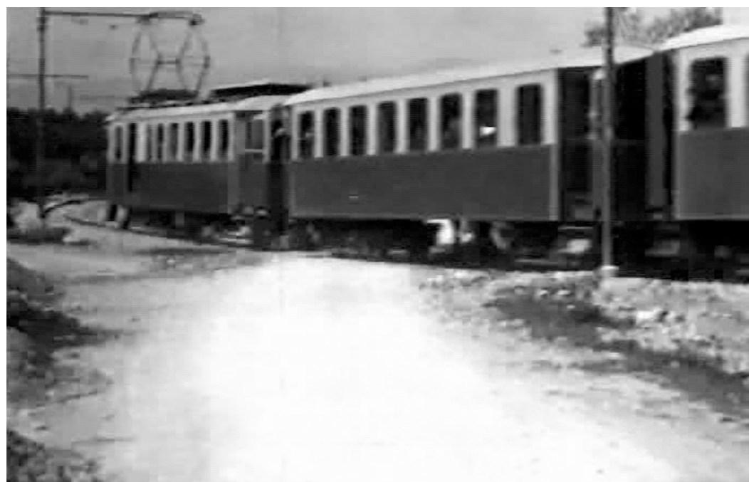
Anni '30 - Convoglio FEA incrocia la strada provinciale "Montesilvano-Penne" (oggi SR 151), nei pressi della casa cantoniera "Valentini", di Loreto Aprutino. - Collezione ACAF.
