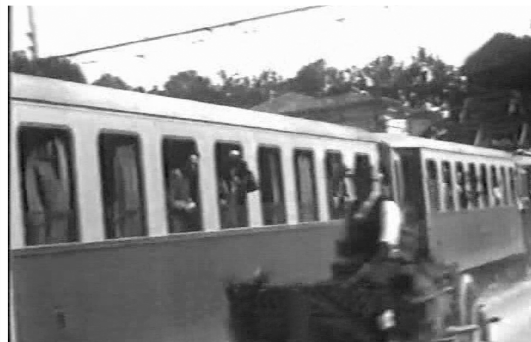
Anni '30 - La doppia sospensione sulla mensola per la catenaria di alimentazione elettrica, indica la presenza del doppio binario di cui era dotata la fermata di "Santa Filomena", nella quale la trazione elettrica "conviveva" con quella animale. - Collezione ACAF.
