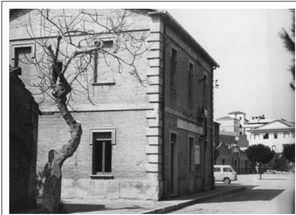
2 aprile 1981 - Fabbricato viaggiatori della stazione di Montesilvano spiaggia (ex lato binari). - Foto Muscolino.
