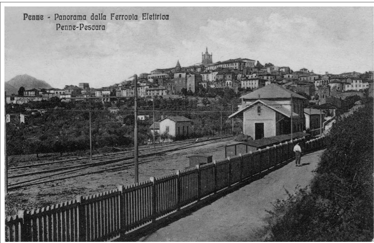
Scorcio del piazzale merci della stazione di Penne. - Collezione Ezio Faieta.
