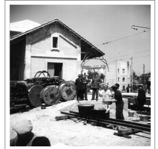
Aprile 1949 - Il personale F.E.A. festeggia la fine dei lavori per il ripristino del servizio ferroviario, nella tratta Pescara-Loreto Aprutino. - Foto Sestili.
