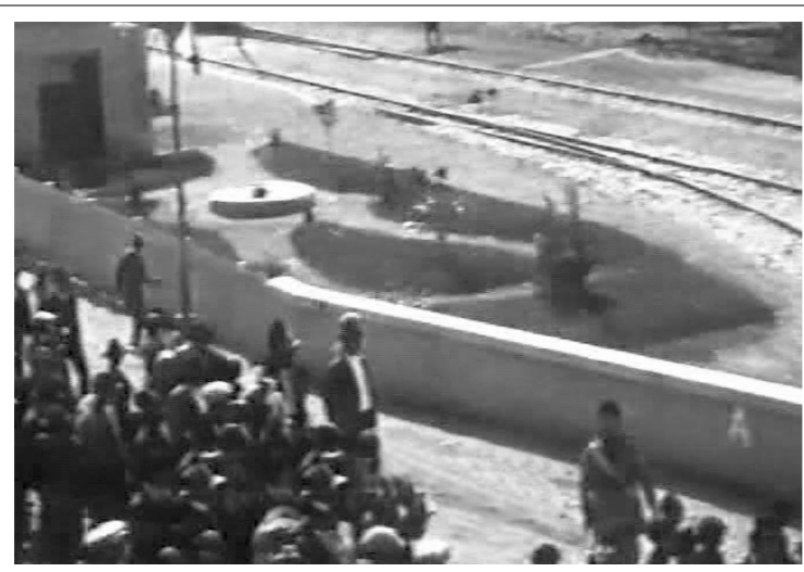
1929 - Particolare del piazzale interno della Stazione di Penne. - Collezione ACAF.
