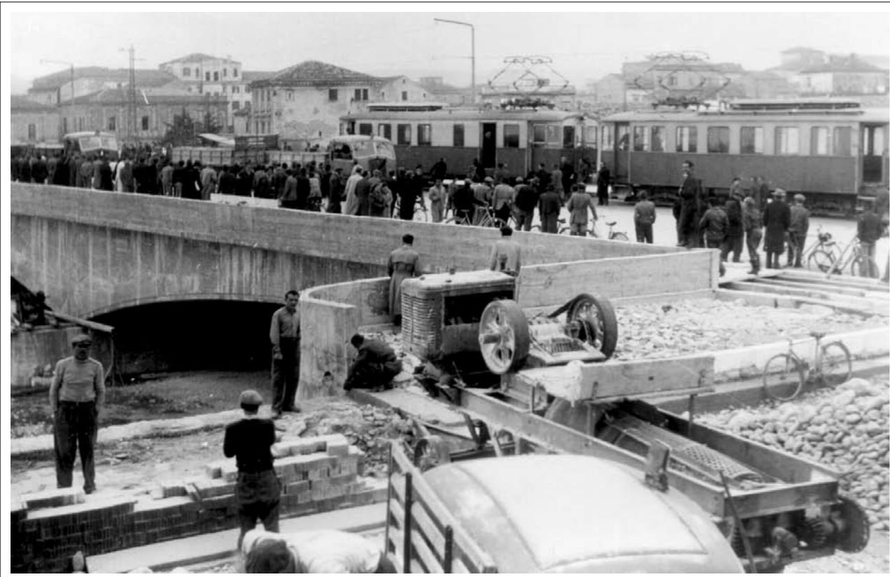
Anni 1946-47 - Collaudo del ponte sul fiume Pescara (attuale ponte Risorgimento), dopo la ricostruzione. - Archivio di Stato di Pescara - Fondo fotografico Genio Civile - fascicolo 59, foto 28.
