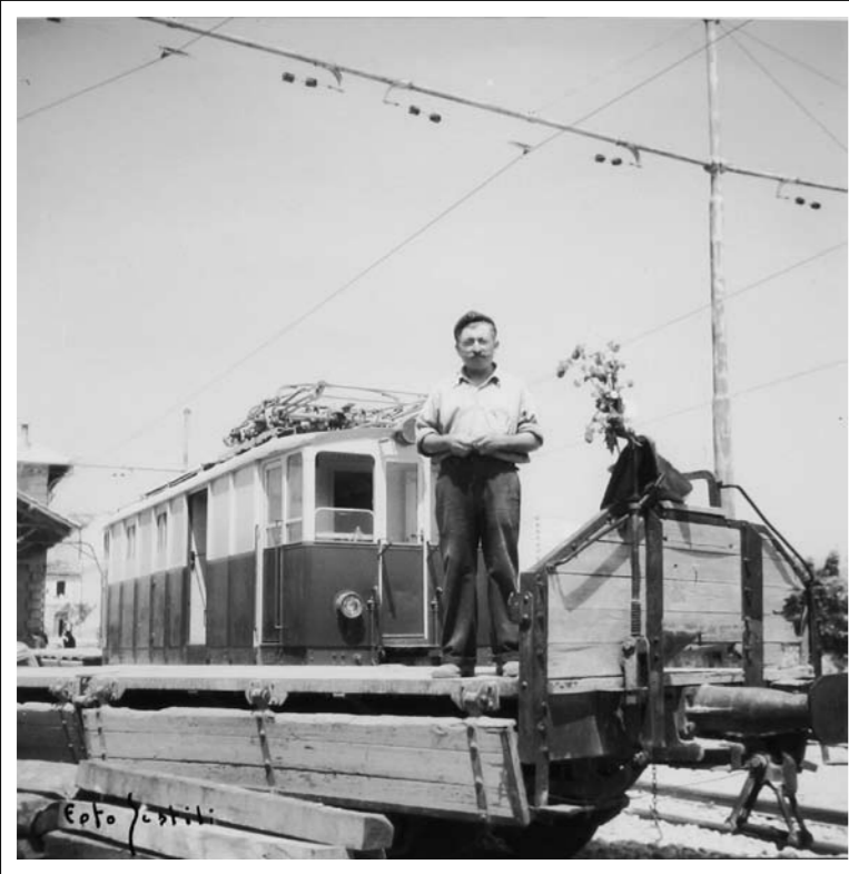
Aprile 1949 - Il personale F.E.A. festeggia la fine dei lavori per il ripristino del servizio ferroviario, nella tratta Pescara-Loreto Aprutino. Il Caposquadra F.E.A. Franco Chiavaroli, in posa su un carro a sponde basse (si notino i fiori esposti sulla maniglia del freno a mano). - Foto Sestili.
