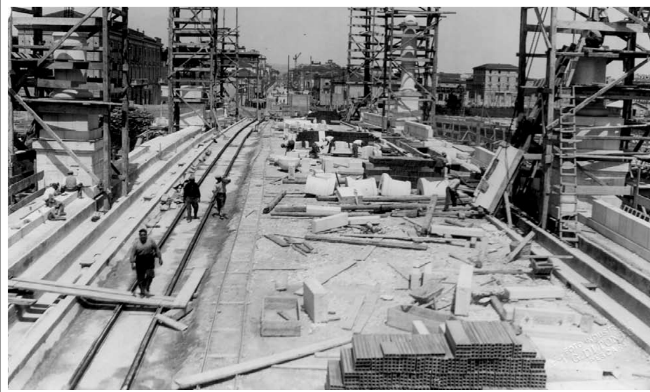
1933 - Lavori per la costruzione del ponte Littorio (attuale ponte Risorgimento) sul fiume Pescara. In evidenza i binari della F.E.A. - Archivio di Stato di Pescara; Fondo fotografico Genio Civile, fascicolo 59, foto 2.
